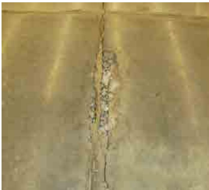
Рис. 1. Разбивка и крошение швов, швы расходятся
