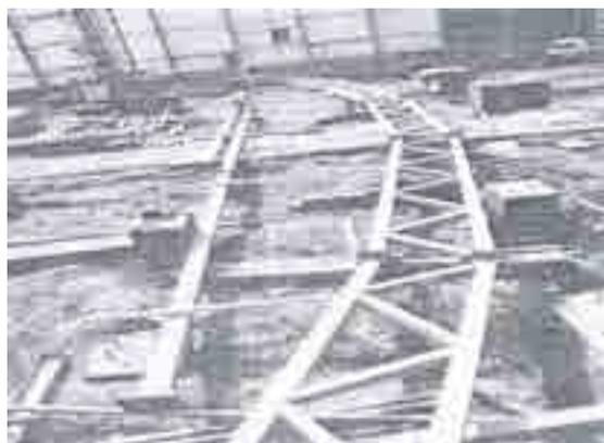
Рис.1 Процесс укрупнительной сборки частей арки
