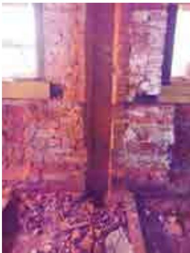
Рис.1 Устройство штробы под будущий монолитный каркас
