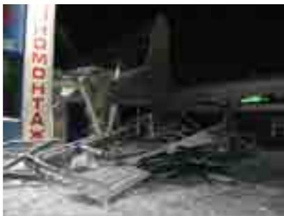
Рис.2. Обрушение кровли и элементов каркаса пристройки из ЛСТК в Кировской области
