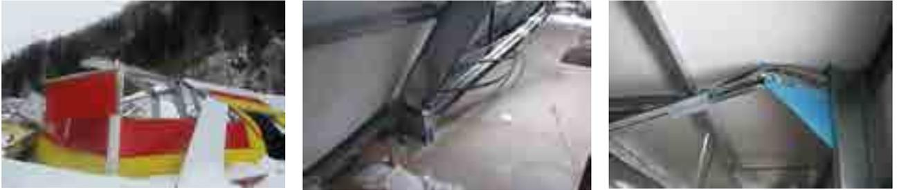
Рис.1 - Обрушение производственного здания из ЛСТК на территории Багиатского завода в Южной Осетии [5]
