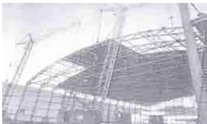
Рис.3 Процесс установки арки в проектное положение
