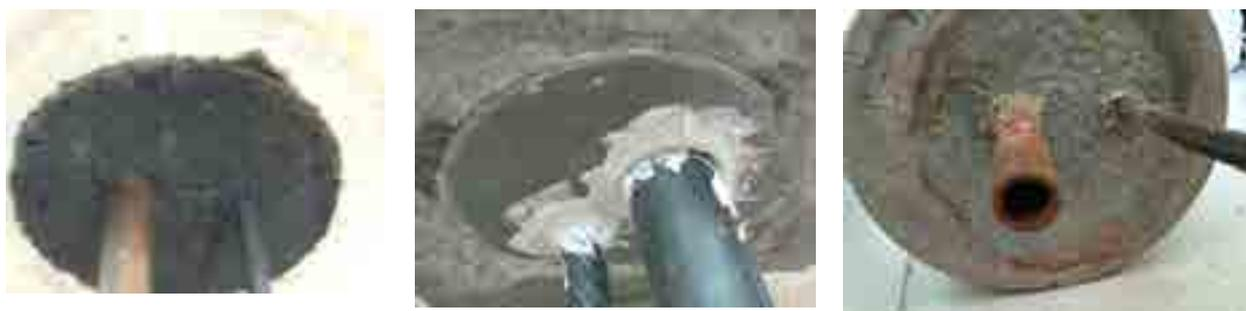
а) Проходка CFS-S SIL LD б) Проходка CFS-S SIL MD в) Проходка CFS-S SIL MD
