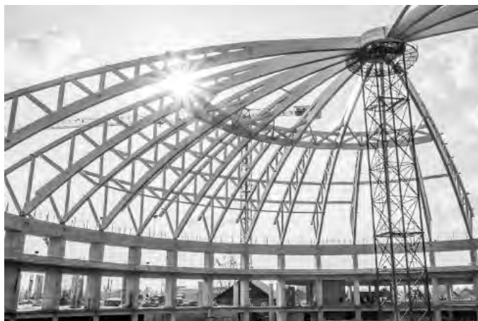
Рис. 1. Возведение деревянного купола из клее-фанерных полуарок
