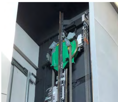
Рис. 2. Безредукторная лебёдка KONE EcoDisc
