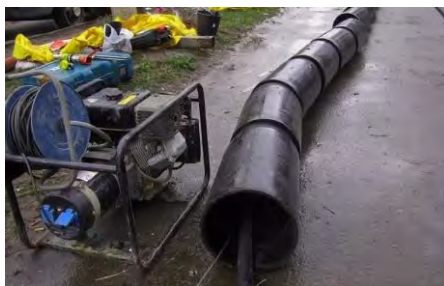
Рис.2. ПЭ модули для наращивания нового трубопровода
