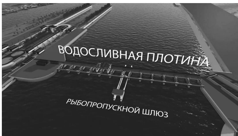
Рис.1. Водосливная плотина с рыбопропускным шлюзом.
