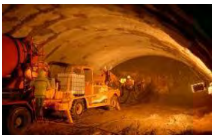
Рис. 1. Усиление конструкций тоннеля методом пневмобетонирования
