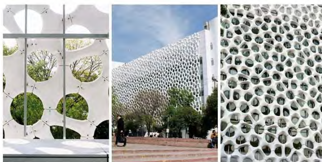
Рис. 3. Госпиталь Torre de Especialidades в Мехико
