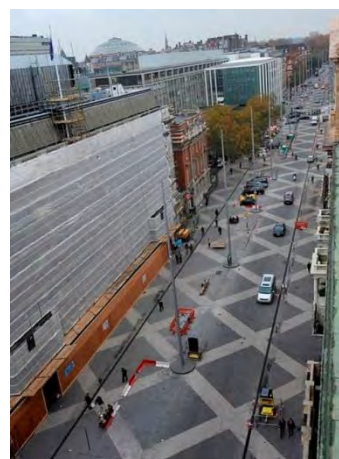
Рис. 4. Улица после реконструкции
