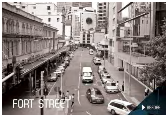
Рис. 1. Улица до реконструкции
