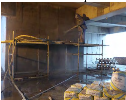
Рис. 2. Применение технологии пневматического бетонирования при строительстве соборной мечети в городе Уфа
