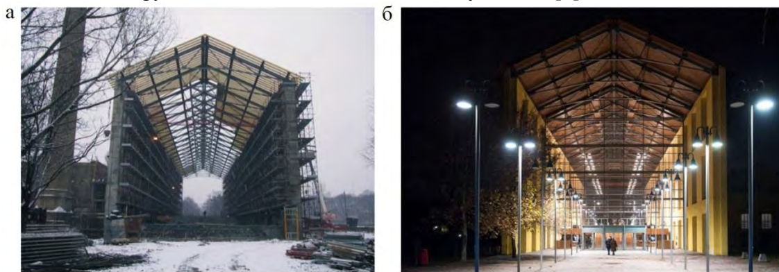
Рис. 1. Южный фасад завода: а - в процессе реконструкции, б - после реконструкции
