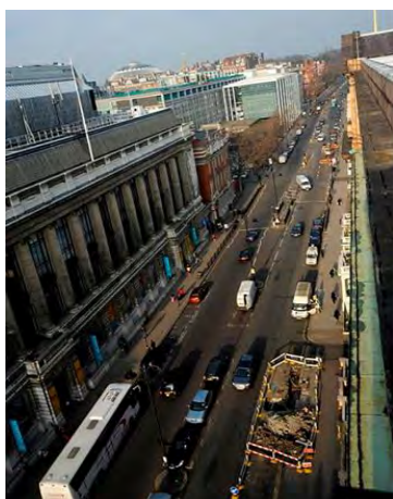
Рис. 3. Улица до реконструкции
