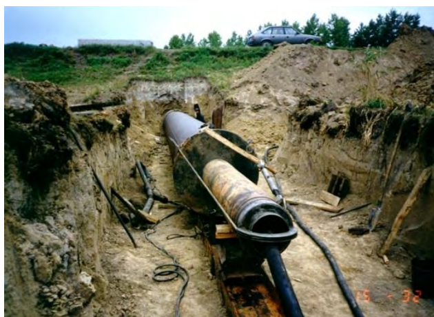
Рис. 6. Пневмопробойник при замене трубопровода
