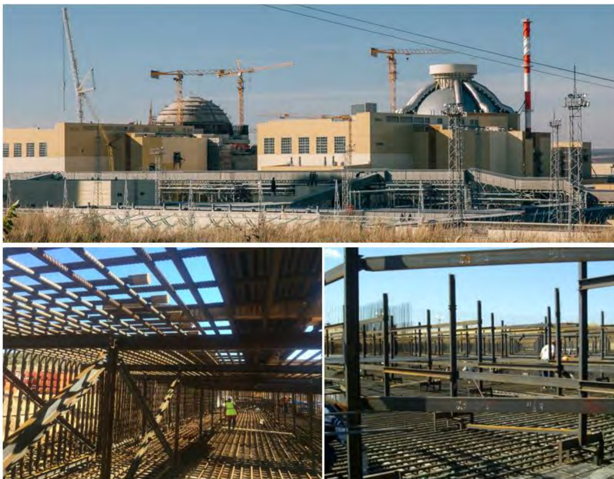
Рис. 1. Общий вид современной АЭС и армирование фундаментной плиты здания реактора
