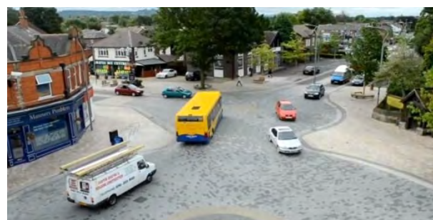
Рис. 6. Улица после реконструкции
