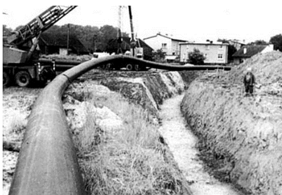
Рис. 4. Траншейный способ замены трубопровода
