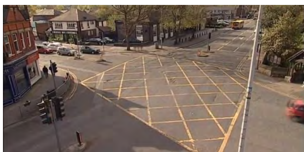
Рис. 5. Улица до реконструкции
