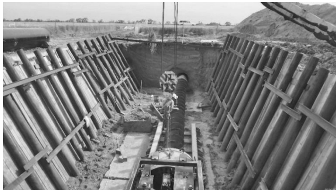
Рис. 5. Бестраншейный способ ремонта трубопровода
