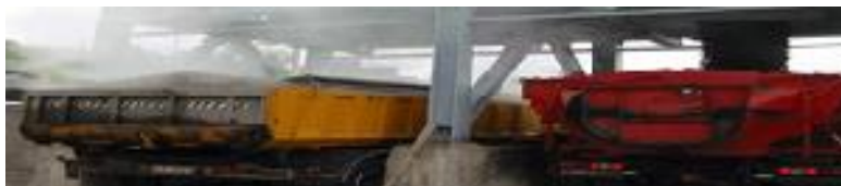
Рис. 1. Задымленность и выбросы горячей (слева) и теплой асфальтобетонной смеси
