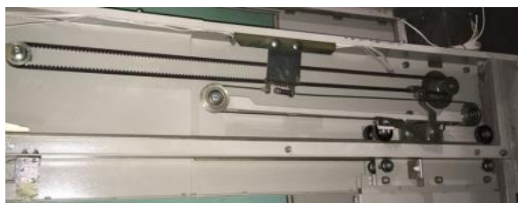
Рис. 3. Конструкция привода дверей до модернизации
