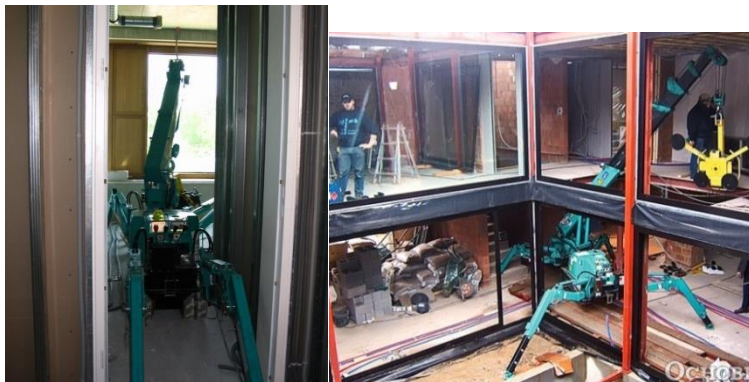
Рис. 1. Примеры расположения крана-паука в замкнутом пространстве [1]
