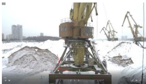
Рис. 2. Портал крана Ганц с дефектами
