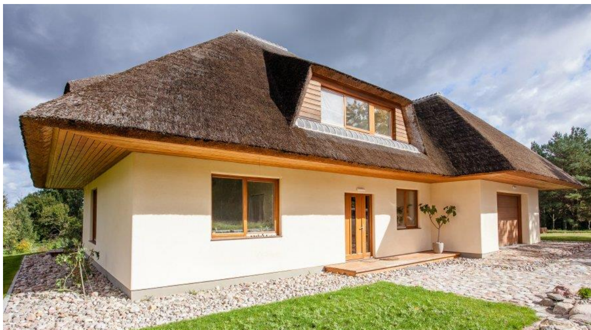
Рис. 3. Здание из соломенных панелей
