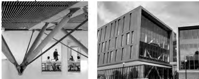
Рис.1. Конструкторское здание Массачусетского университета в Амхерсте, США.
