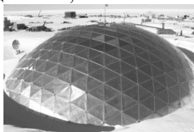
Рис. 1. Здание каркасной конструкцией с покрытием из пленки ETFE в районах Крайнего Севера
