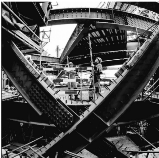
Рис. 3 Аутригер башня “Лахта центр”
