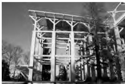
Рис. 1. Офис Good Wood Plaza в процессе строительства
