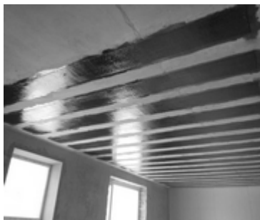
Рис. 1. Усиление плит перекрытия углеволокном
