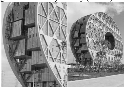
Рис. 2. Круглый небоскреб Guangzhou Circle в Гуанчжоу (Китай)
