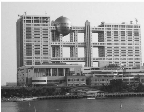
Рис. 3. здание штаб-квартиры Fuji TV на острове Одайба .
