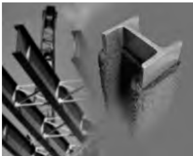
Рис. 1. Пример огнезащиты конструкции
