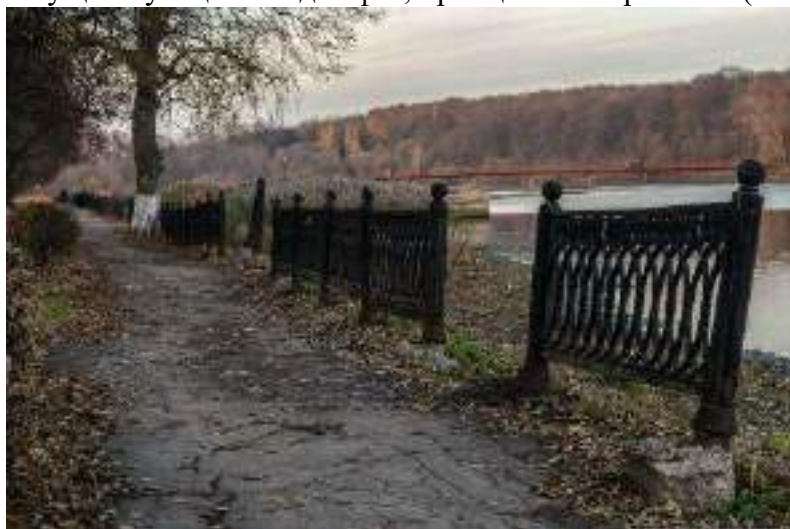
Рисунок 4. Набережная Богородска до благоустройства.
