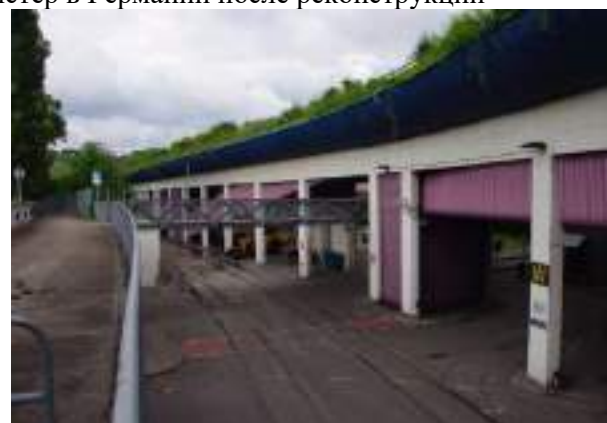
Рис. 5. Электростанция Штутгарт-Мюнстер в Германии после реконструкции
