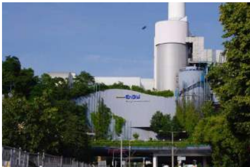
Рис. 3. Электростанция Штутгарт-Мюнстер в Германии после реконструкции
