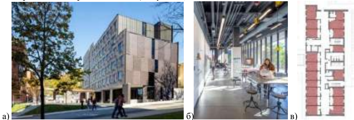
Рисунок 2. а) Студенческое общежитие RISD North Hall от NADAAA, Провиденс, США, 2019 год; б) Вид творческой мастерской на 1-ом этаже; в) План типового этажа.
