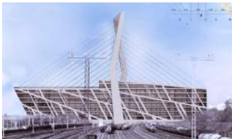
Рис.1 Здание-мост с использованием вантовой конструкции в районе железнодорожной станции Лось. Арх. А.Демьяненко
