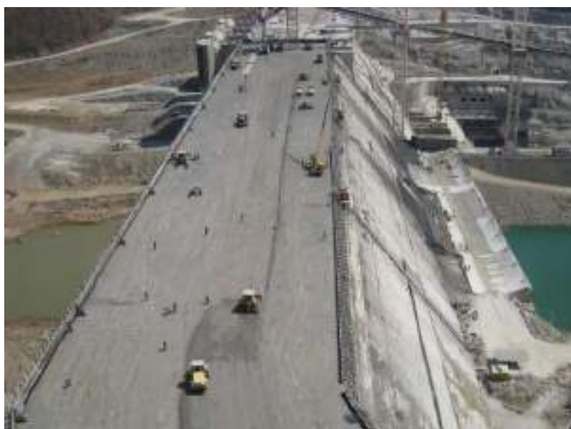
Рис. 1. Строительство плотины с использованием укатанного бетона
