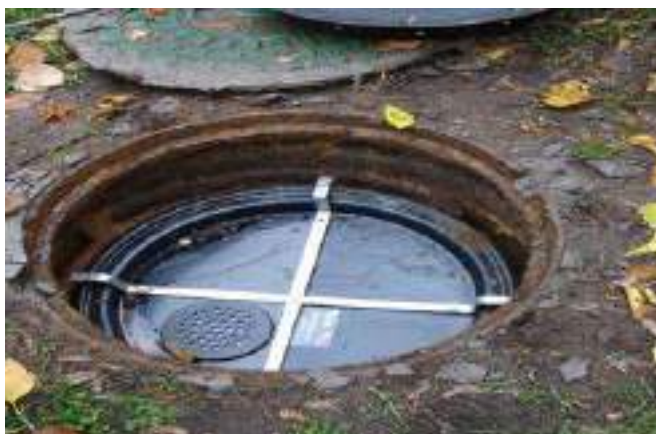
Рис. 1. Конструкция биологического очистителя для нейтрализации отходящих газов от колодцев
