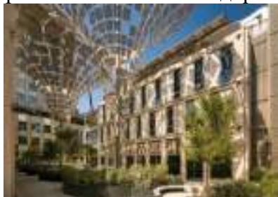
рис. 5. Конструкции для затенения пешеходных дорожек в стиле ладони (состоящие из 52 легких металлических конструкций высотой 16 м)
