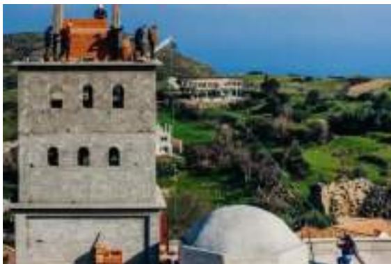
Рис 9 Фотография строительства негабаритного религиозного здания для минимального количества операторов, полагающихся на естественную среду.
