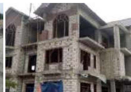
В, несущая стена
