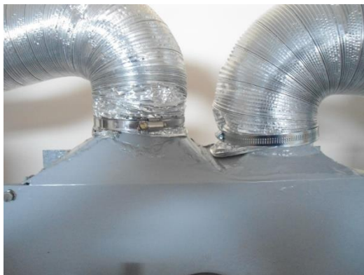
Рис. 3. Фотография входного патрубка (конфузор) и выходного патрубка (диффузор)
