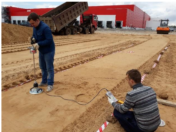
Рис. 1. Участок проведения исследований по уплотнению грунта вибрационным катком DM-617 и измерение динамического модуля деформации грунта E_{vd}
