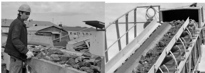
Рис.3, 4 Переработка бетона в щебень
