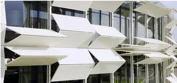
Рис. 2. Элементы динамического фасада выставочного павильона Kiefer Technic.
