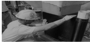
Рис. 2. Усиление колонн углеродными лентами
