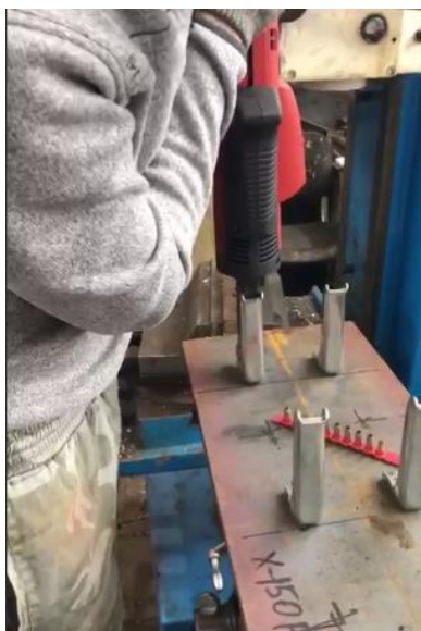
Рисунок 3.11 – Монтаж уголковых анкерных упоров
