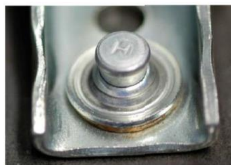
Рисунок 3.7 – Корректно установленный дюбель-гвоздь
