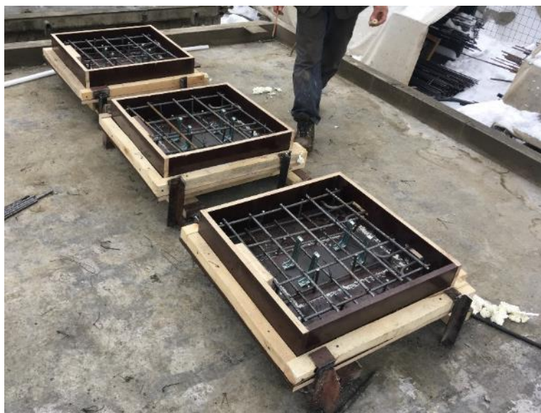
Рисунок 3.12 – Образцы для второго этапа испытаний перед заливкой бетона
