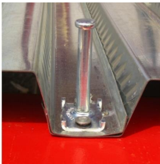
Рисунок 1.10 – Общий вид анкерного упора Tecnaria STF Connector
