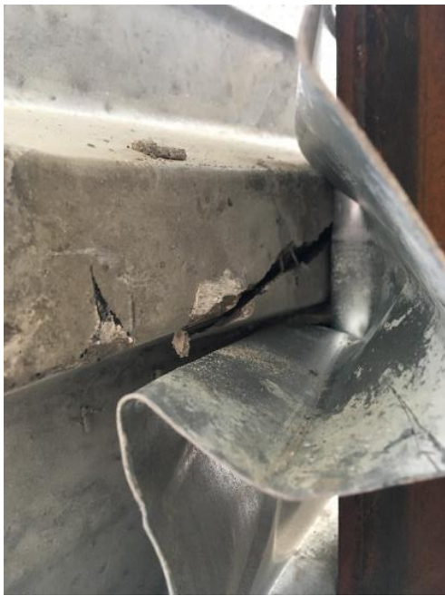
Рисунок 3.68 – Продавливание бетонного ребра
