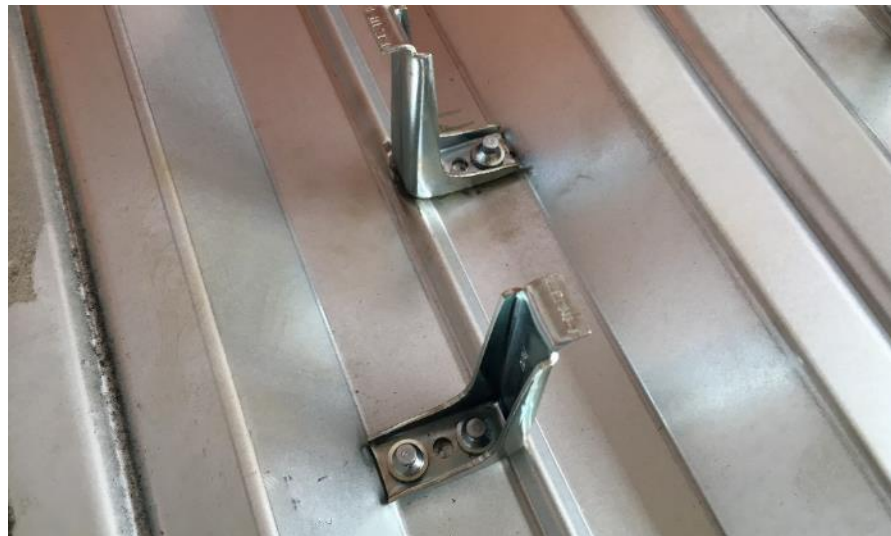
Рисунок 3.20 – Вид анкерных упоров в серии X-150P-N44 после установки
