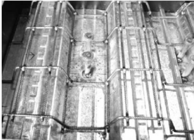
Рисунок 4.30 – Вариант конструктивного армирования бетонного ребра
