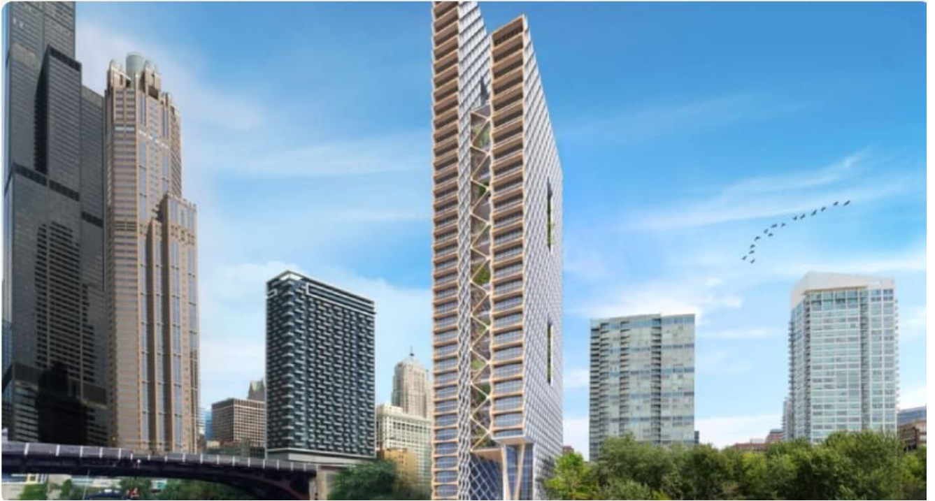
Рисунок А.19. – визуализация проекта 80-ти этажного жилого здания, разработанное архитектурной студией Perkins+Will, Чикаго. Диагональная решётка является элементом фасадной системы из CLT-системы.
