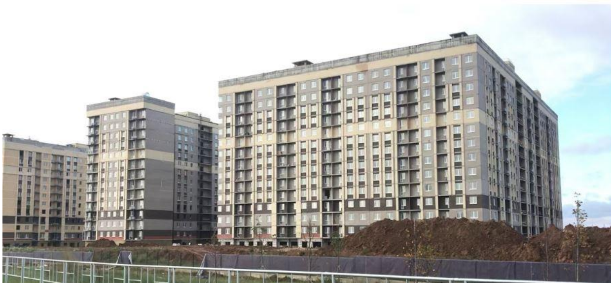
Рисунок А.26. – ЖК «Заречье парк» в Москве ГК Самолет. Визуализация проектного решения. Фортификация существующего положения.
