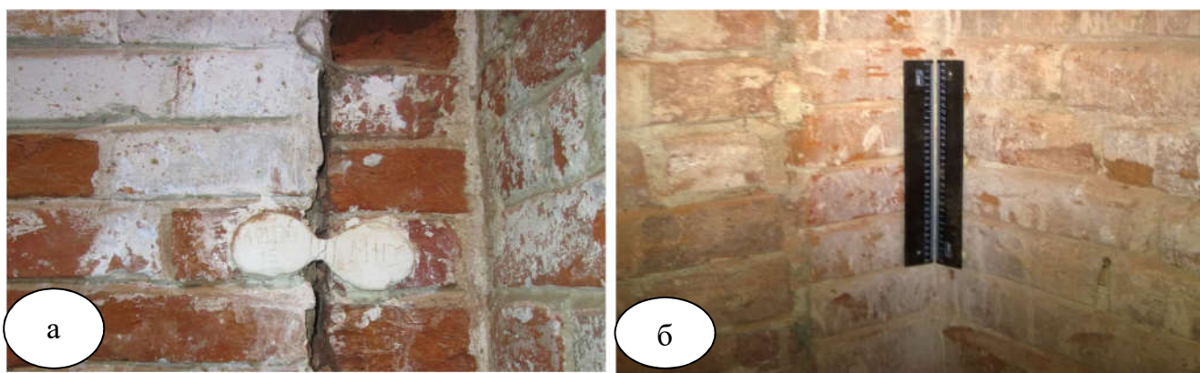
Рисунок 4.2 – Установка маяков: а) маяк М10; б) угловой маяк
