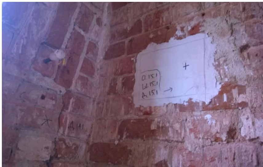
Рисунок 3.21 – Точка для снятия замеров отклонений на внутренней части стены по оси б/Б÷В
