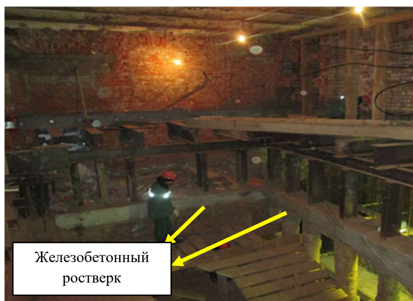
Рисунок 4.5 – Устройство ростверков
