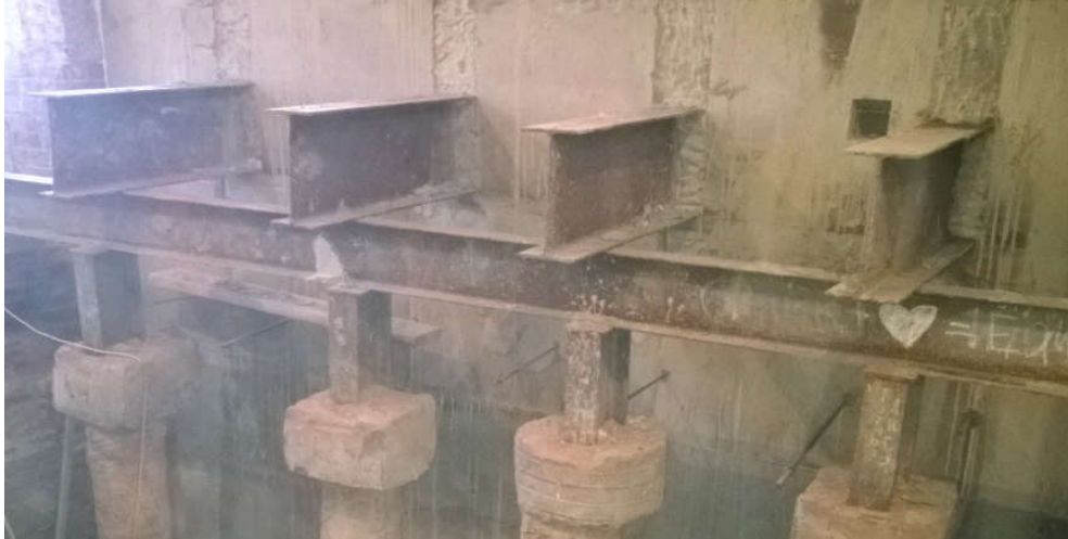
Рисунок 4.6 – Устройство поперечных балок
