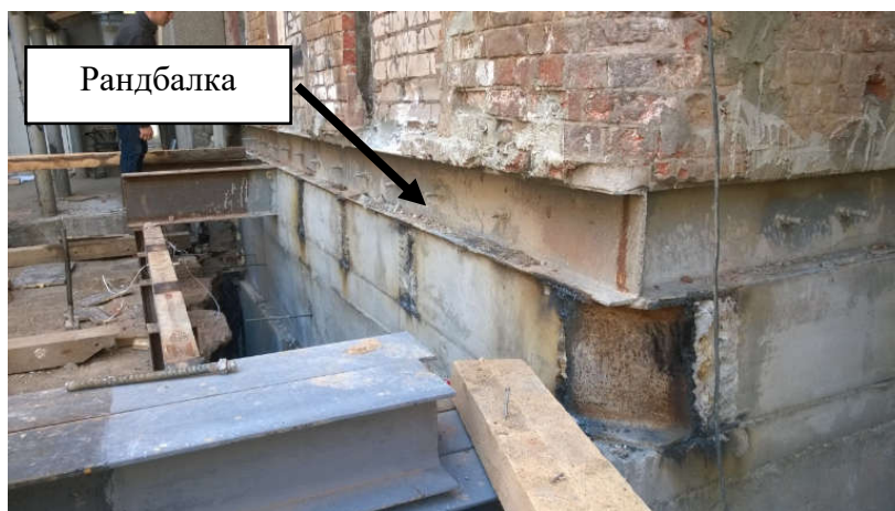
Рисунок 4.3 – Устройство рандбалки
