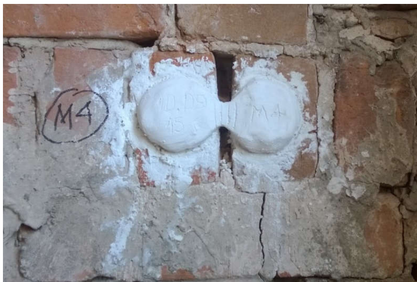
Рисунок 3.24 – Гипсовый маяк М4 специальной формы
