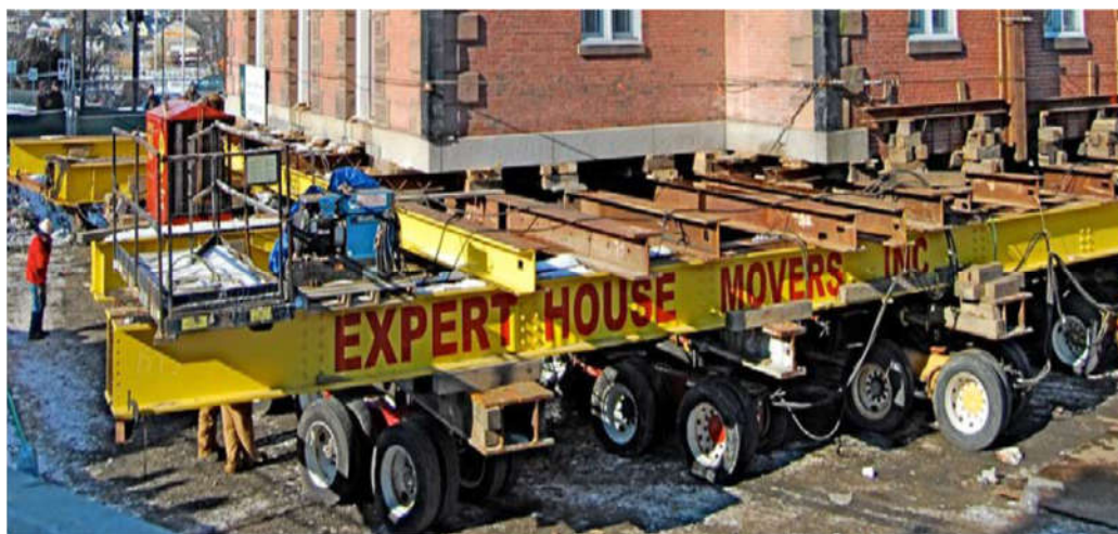
Рисунок 1.6 – Передвижка здания церкви XIX в, г. Сейлем, штат Массачусетс, США
