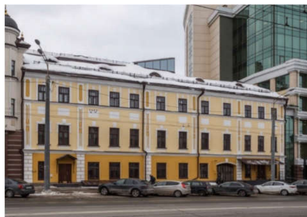
Рисунок 3.20 – Фасад здания по ул. Пушкина после реконструкции
