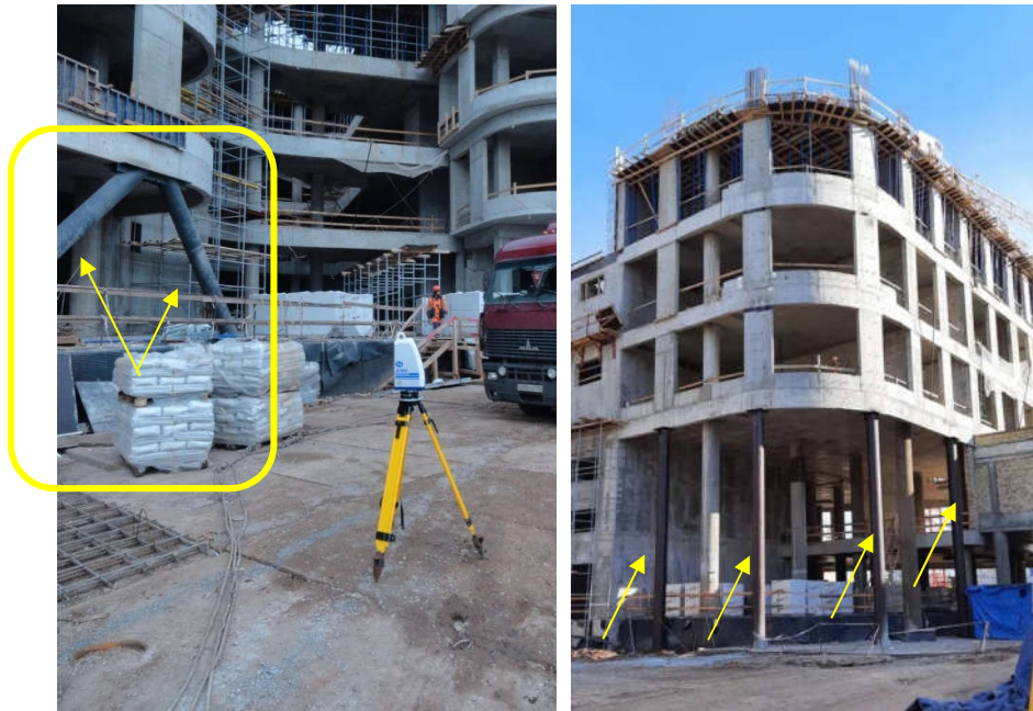
Рисунок 3.38 – Временные поддерживающие конструкции
