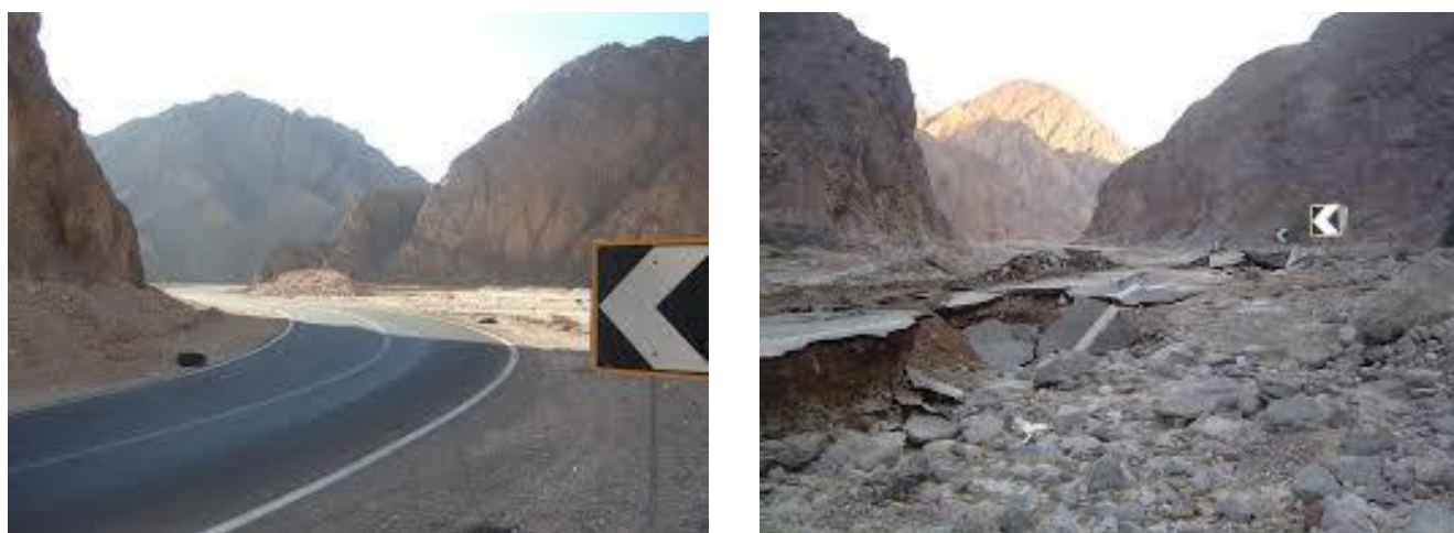
Рисунок 3.1 — Главная автомагистраль, проходящая через выезд из Вади-Ватир, в нормальном состоянии и после наводнения в октябре 2008 года [36].
